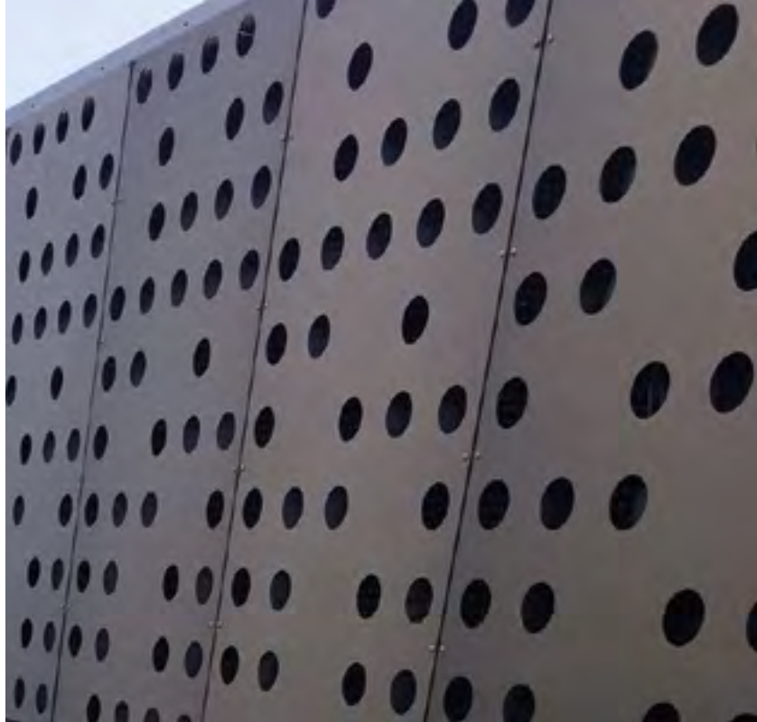
Facade i anodiserede aluminiumsplader. - Foto: Knud Erik Hjerrild
