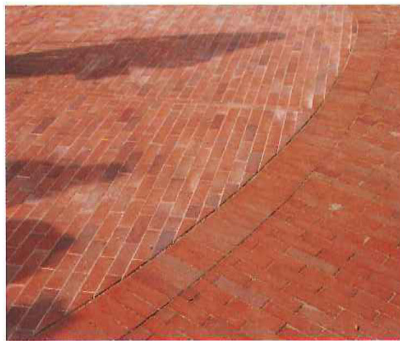
Bassinet: 1. Vanddyserne inviterer til leg, 2. Et rulleskifte markerer bassinets cirkulære form, 3. Vanddyserne skaber variation og tilfører pladsen en ny lyddimension The pool: 1. Water jets invite play, 2. A brick rowlock pattern marks the pools circular form, 3. Water jets offer variation and give the square a new sound dimension
